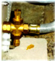
Pompe à chaleur
