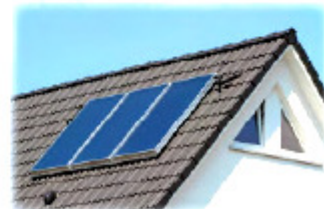
Panneaux solaires thermiques
